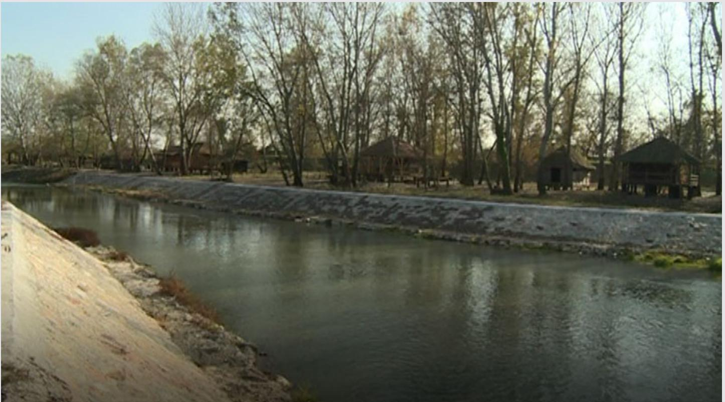
U okviru projekta regulacije i uređenja obale reke Kolubare u Lajkovcu, počela je realizacija druge faze. Aktivnostima je predviđen nastavak radova na obaloutvrdi sa obe strane reke u dužini od 300 metara. Pored novog izgleda omiljenog lajkovačkog izletišta na ovaj način će biti povećana zaštita od poplava i smanjena opasnost od izlivanja Kolubare u ovom delu toka. Po rečima predsednika opštine Andrije Živkovića početak radova je planiran tokom leta, ali se čekalo na odobrenje JP "Srbijavode".
